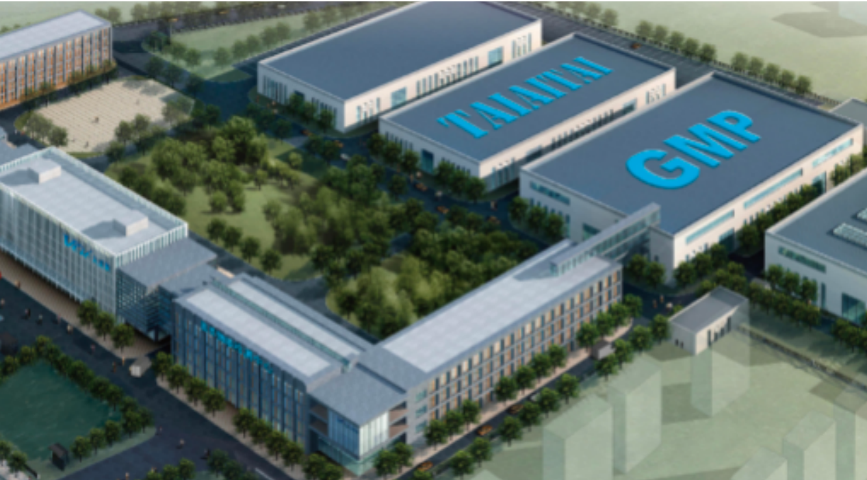
河北大厂 (2006年投产) Dachang, Hebei (Commissioned in 2006)
